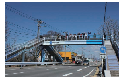
“空色”に塗り替えられた新屋横断歩道橋
